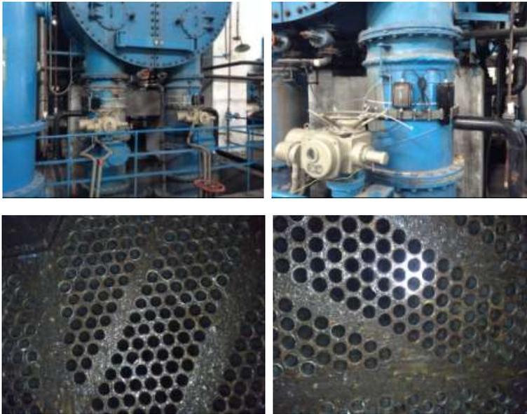
淄博矿业集团有限责任公司埠村煤矸石热电厂隶属山东能源集团,总装机容量 49 兆瓦,企业自备综合利用电厂。近两年来电厂用水一直比较紧张,特别是用污水处理站处理后的污水后,水质变差,凝汽器结垢影响热效率的问题一直困扰电厂。四号机组为 25 兆瓦机组,自 2007 年 1 月机组已经使用 8 年,其凝汽器换热效率逐渐下降。经过现场运行人员分析,主要原因是因为循环水硬度高,补水为矿井废水和污水处理站,这些水源直接导致凝汽器容易沉积生物淤泥和结垢,循环水池和凉水塔内很容易产生藻类和微生物,使凝汽器传热热阻增大,换热端差增大,真空度逐渐下降。虽然停机检修时对凝汽器采取强化人工清洗,运行中定期进行胶球清洗,但效果均不明显。2014 年 4 月 20 日,在电厂 4 号机凝汽器进水端装了 2 套
